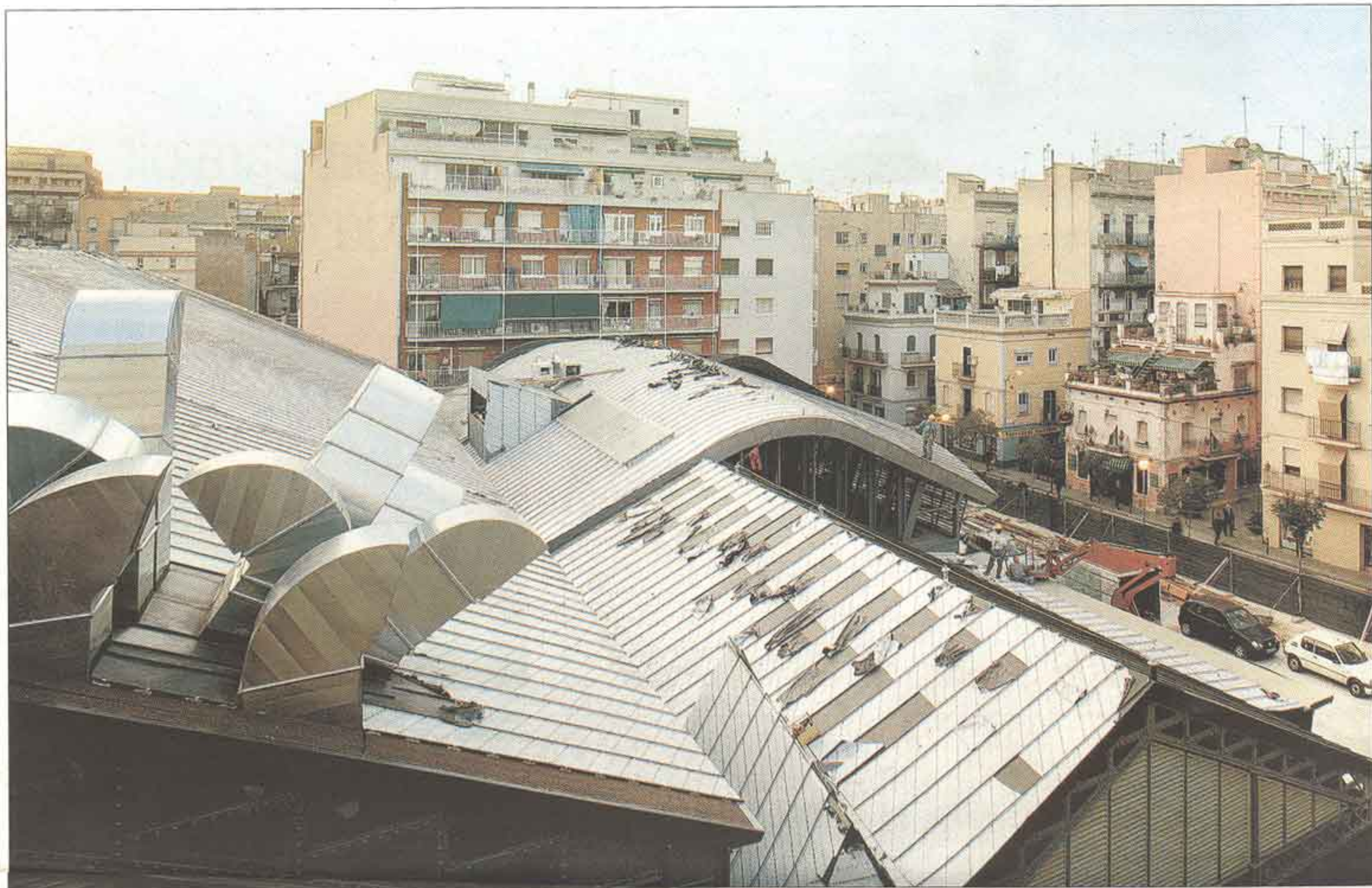
El tejado del mercado de la Barceloneta, durante el proceso de remodelación del recinto, que se inaugurará el próximo 3 de abril.
